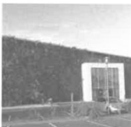
Exemples : Mur végétalisé à partir du sol.
